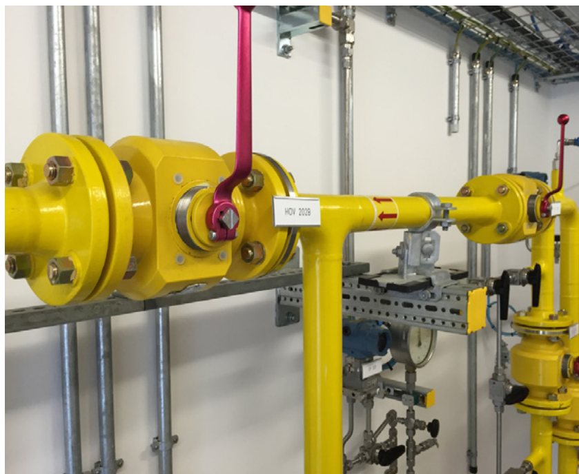
Bild 3: Kugelhähne für Wasserstoff mit Antrieb und handbetrieben
