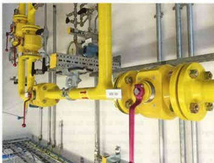
**Zuverlässige Absperrung: Hartmann-Kugelhähne mit Antrieb und handbetrieben**
