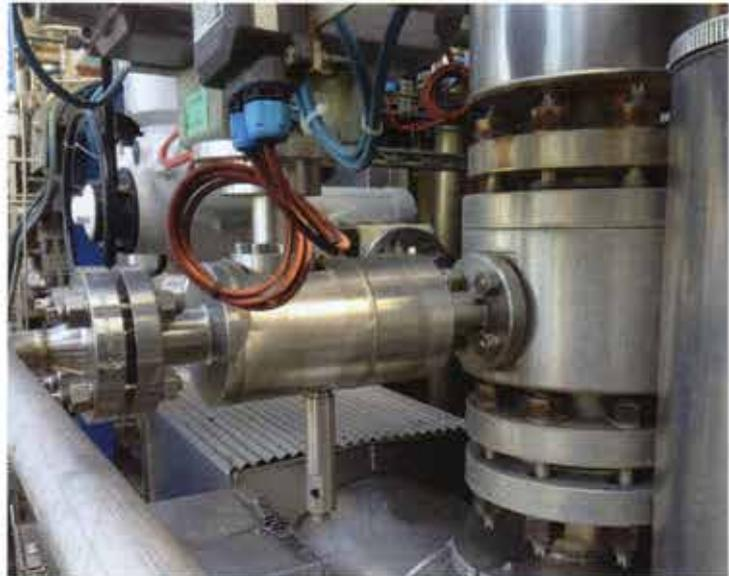
**Bild 2:** Absolut gasdicht: die rein metallisch dichtenden Kugelhähne aus Inconel 625® (Vollmaterial) in der POX-Vergasungsanlage Brunsbüttel
