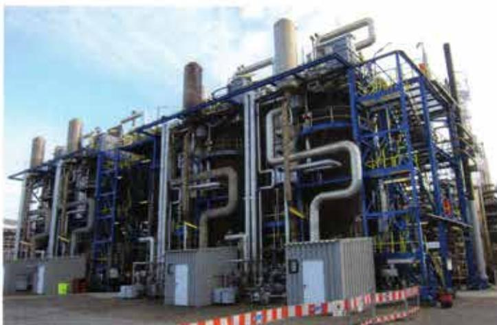
Bild 1: Die vier Reaktoren der POX-Vergasungsanlage bei Yara Brunsbüttel
