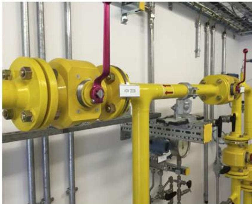
Bild 3: Kugelhähne für Wasserstoff mit Antrieb und handbetrieben
