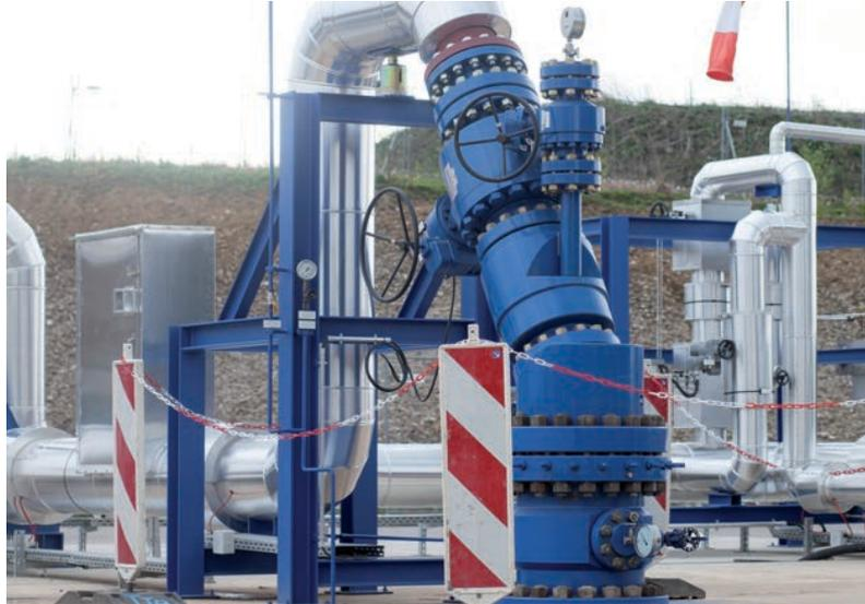
Blauer Bohrlochkopf von Hartmann für die Injektionsbohrung.
