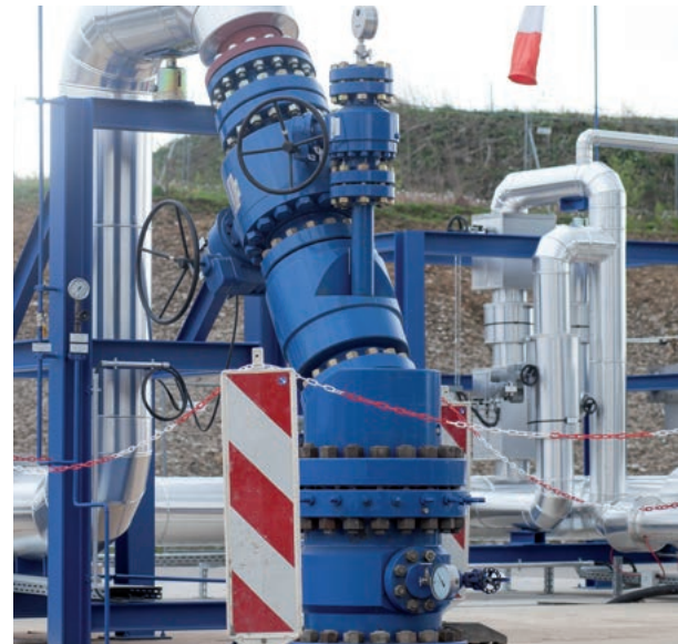
▲ Bohrlochkopf von Hartmann für die Injektionsbohrung
