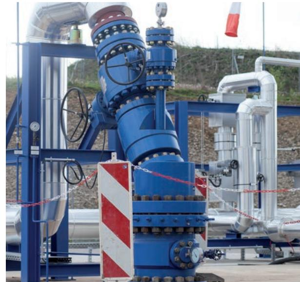
▲ Bohrlochkopf von Hartmann für die Injektionsbohrung
