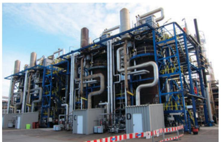
Bild 1: Die vier Reaktoren der POX-Vergasungsanlage bei Yara Brunsbüttel
