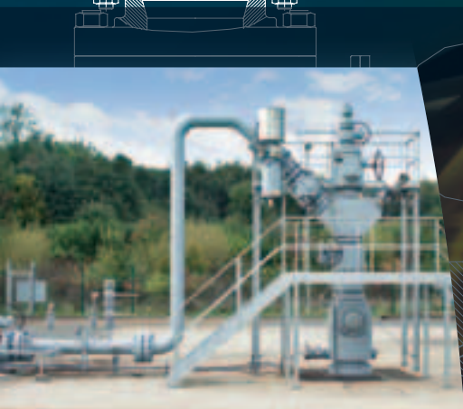
Erdgas-Bohrlochkopf
