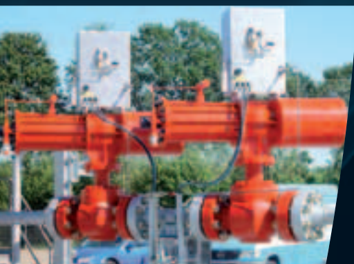
Schnellschlussarmaturen für den H 2 S-Einsatz
