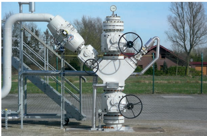
Zuverlässige Kombination: Hartmann Gasförderkopf mit gasdichten, rein metallisch dichtenden Kugelhähnen
