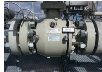
Die speziell angefertigten Kugelhähne haben die Leckrate „A“
