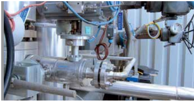
Absolut gasdicht: die rein metallisch dichtenden Kugelhähne aus Inconel 625® (Vollmaterial) von Hartmann Valves
