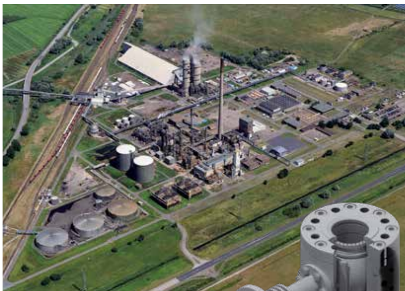
Das Werk Yara Brunsbüttel am Nord-Ostsee-Kanal produziert Ammoniak und Harnstoff sowie technische Gase
