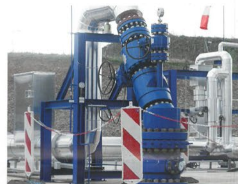
Projektbeispiel Traunreut: Hartmann Bohrkopf für die Injektionsbohrung
