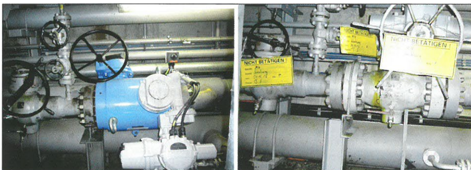
Maßgeschneiderte Konstruktion: An der Haupteinpressleitung zu den Verdichtern waren die Sperrstrecken mit einem eingeschweißten und einem geflanschten Kugelhahn realisiert (rechts). Die kompakte TBV-Ausführung, die den geflanschten alten Kugelhahn ersetzt, machte die Erneuerung der Sperrstrecke ohne Schweißarbeiten möglich (links)
