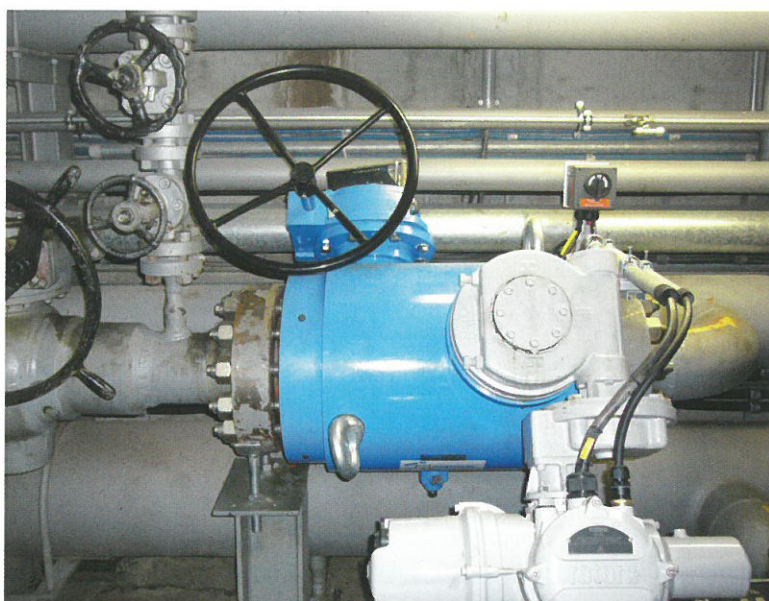
Rechts: Maßgeschneidert konstruiert: Die kompakte TBV-Ausführung, die den geflanschten alten Kugelhahn ersetzt, machte die Erneuerung der Sperrstrecke ohne Schweißarbeiten möglich
