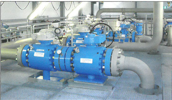
Konventionelle Sperrstrecken: Wartungsfreie Hartmann-Armaturen sorgen für eine sichere Absperrung der Bereiche des Speicherbetriebs, in denen Wartungsarbeiten vorgenommen werden müssen
