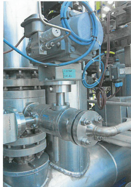
Absolut gasdicht: die rein metallisch dichtenden Kugelhähne in der Yara POX-Vergasungsanlage in Brunsbüttel
