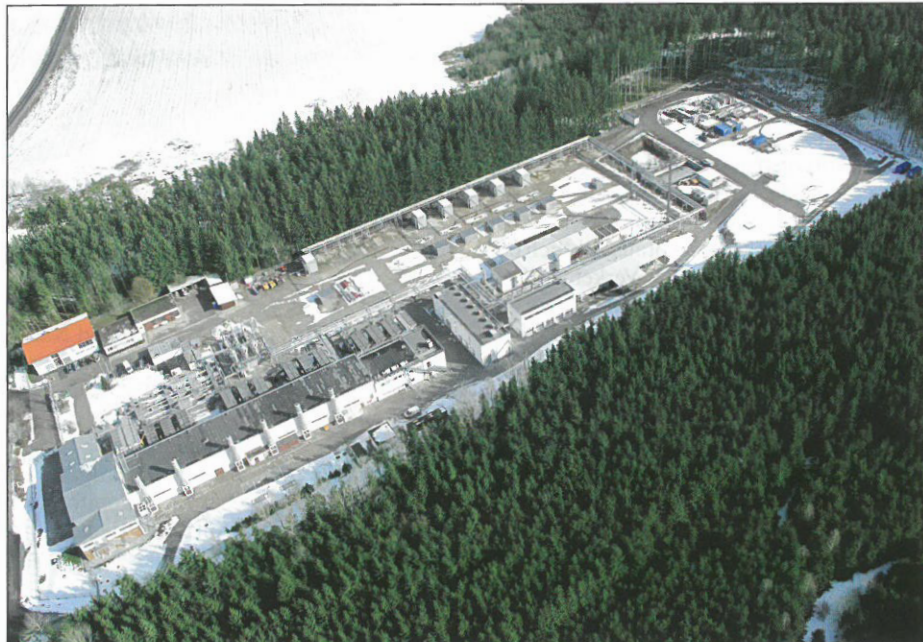
Obertageanlagen des Erdgasspeichers Wolfersberg
