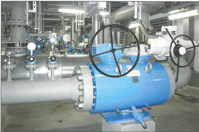
Twin Ball Valve-Sperrstrecke in der Gastrocknung als besonders platzsparende Variante für höchste Sicherheitsansprüche
