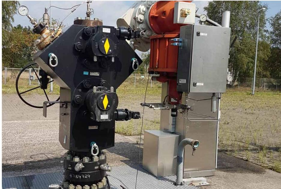
Erfolgreicher Umstieg: Das E-Kreuz mit Kugelhähnen und Schnellschlussarmatur ist nahezu wartungsfrei in der Gasproduktion im Einsatz.
