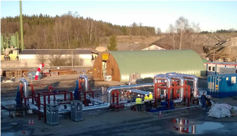
Blick auf die Bohrungsdublette mit den beiden Kopfverflansungen links im Bild.
